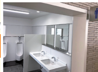
改修されたほつま体育館下トイレ
